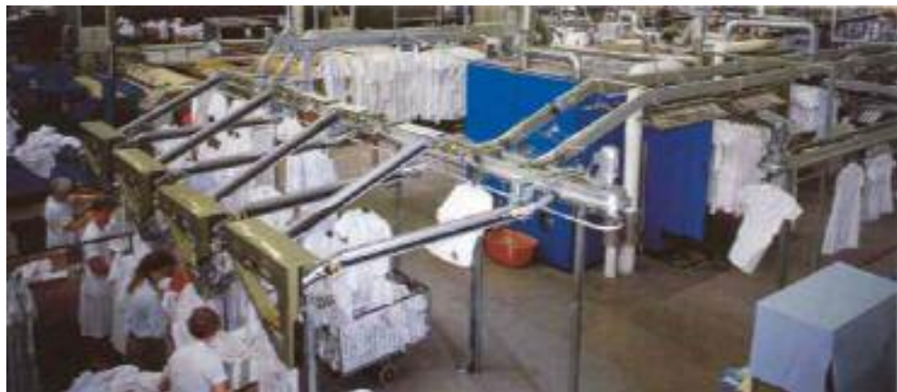
Voorbeeld van hangbaantransport van schoongoed (Landuwasco)
