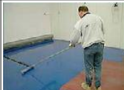
Voorbeeld van een epoxyvloer
